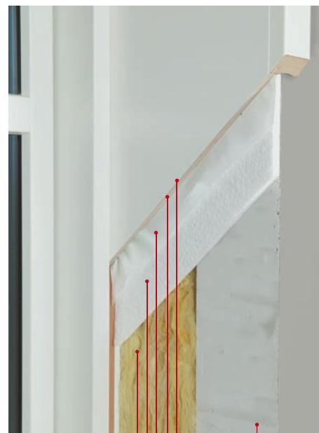
RAL9010 MDF-kerne Dampspærre Isoleringsplade Hulmorsisolering Indermur
