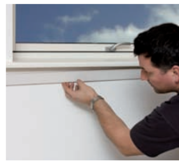
Pres dæklisten i den ønskede position, og dæklistens dobbeltklæbende tape fastholder dæklisten indtil den påførte vedhæftning er hærdet.
