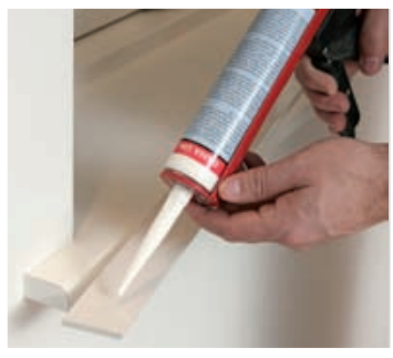
Påfør montagelim, fugemasse eller anden vedhæftning bag på dæklisten.
