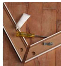
Når lysningerne er samlet sættes de i vindueshullet. Herefter samles listerne med lim og gearingsbeslag.
