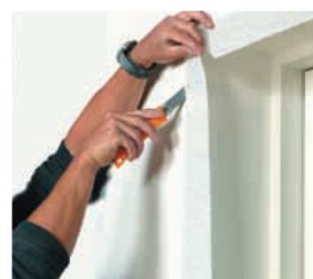
Væv skæres helt til den færdiglakerede lysningskant og væggen males.
