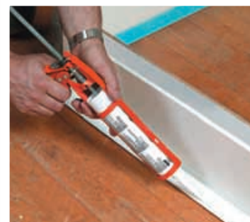
PVC-gerigter og not limes/fuges.
